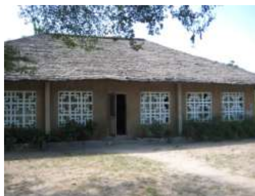
Vue extérieure du campement ASSEB
