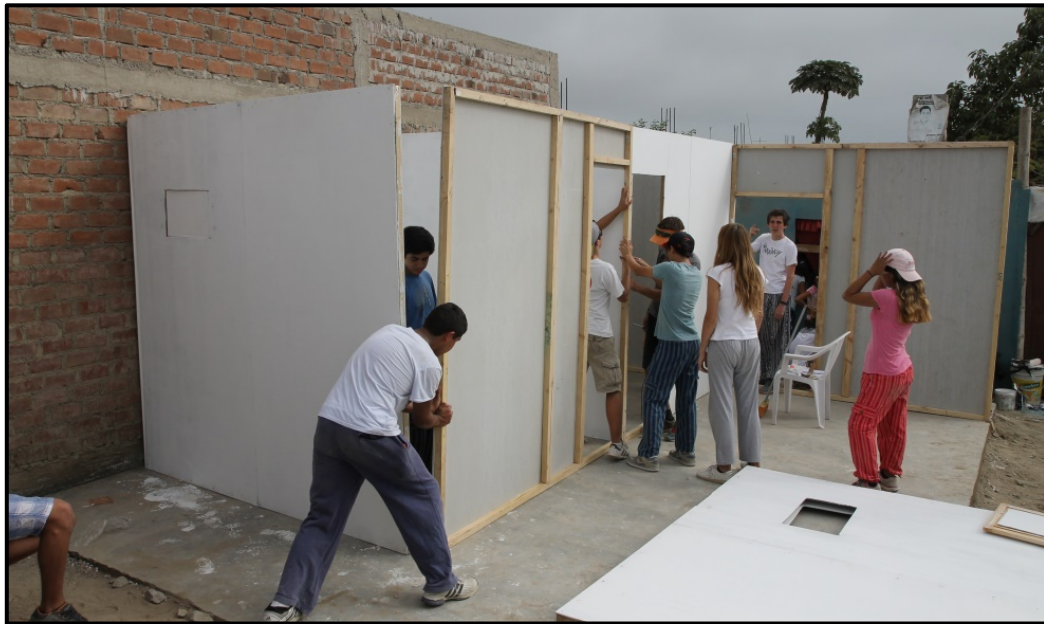
Assemblage des murs
