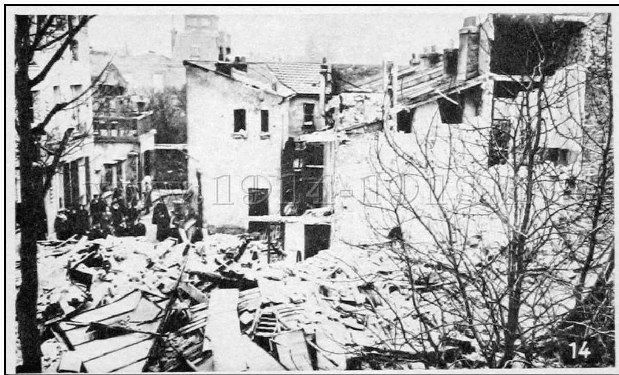
16 ème bombe : maison d'un étage effondrée, 2 morts, 1 blessé.
